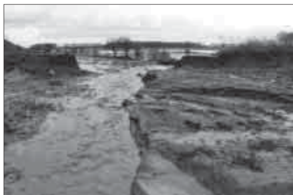
Onstabiele dijken veroorzaakten twee dijkbreuken gedurende de winter van 1999-2000. Foto: Jaak Geebelen
